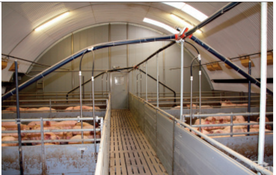
An der höchsten Stelle ist der Rundbogenstall über 5 m hoch. Gutes Stallklima, weniger Hitze Probleme im Sommer, dafür aber etwas mehr Heizbedarf zu Beginn der Mast sind die Folgen des großen Raumvolumens.
