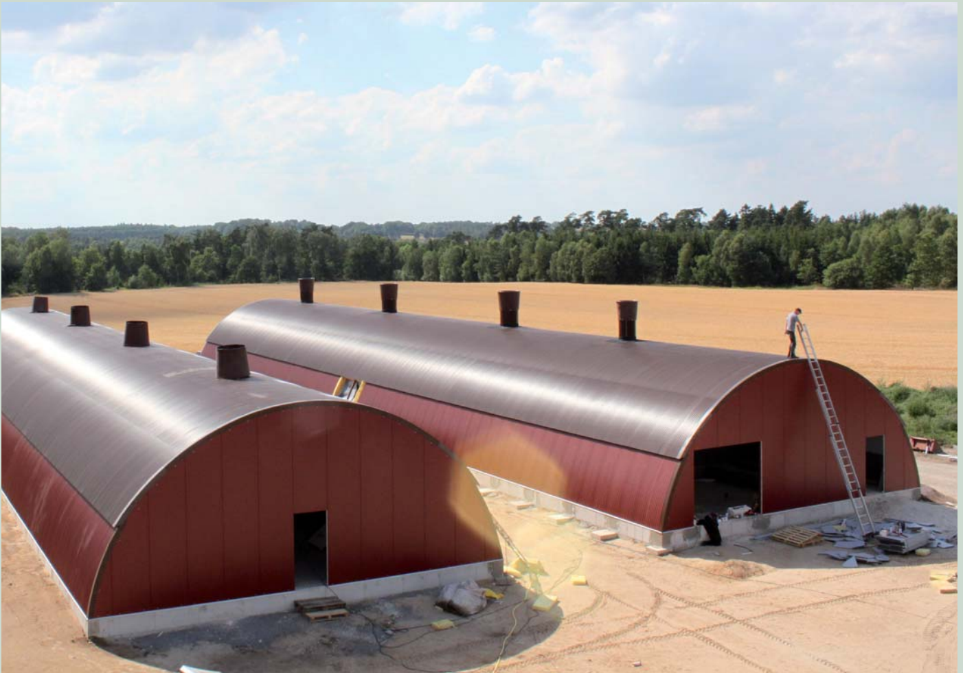
Bild oben: 900er Maststall im nördlichen Niedersachsen, Bj 2010 Hülle inkl. Montage Kosten: ca. 165.000 Euro zzgl. MwSt.
